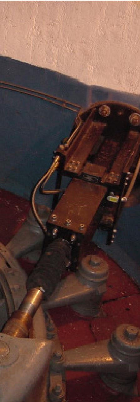
**背景技术：**导叶是一系列可调节的叶片，用于控制流向反动式涡轮机的水流。每个叶片通过机械并联的方式连接到一个可调操作环。顺时针或者逆时针驱动操作环，将导叶定位，调节流向涡轮机的水流。导叶的操作变化与许多因素有关，包括涡轮机轴、有效水头、物理空间和涡轮机的类型。
